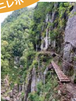
絶壁に穿かれた水平歩道が続く
